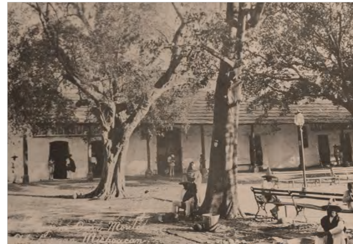
Casa de la Constitución de Apatzingán. Ing. Raúl Chávez, octubre de 1898. Fotografía.
